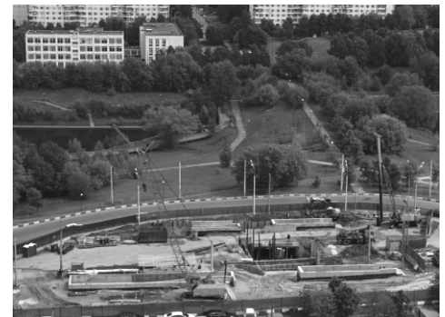
Ведется строительство подземного перехода через Никулинскую улицу.
